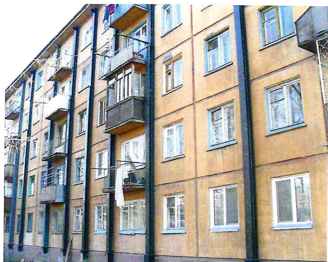
Рис. 3. Общий вид установки колонн снаружи здания
