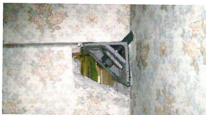
Рис. 5. Часть анкерного устройства, установленная со стороны квартиры
