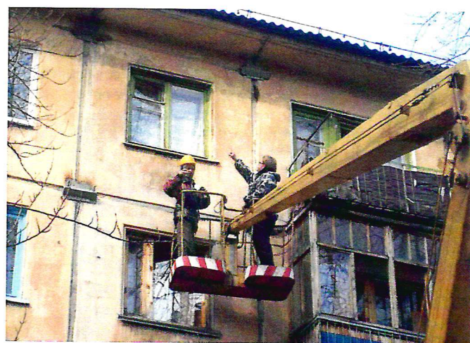
Рис. 6. Установка анкерных устройств в Омске
