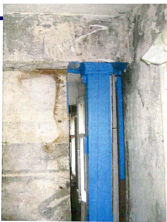
Рис. 2. Усиление при помощи установки колонн изнутри
